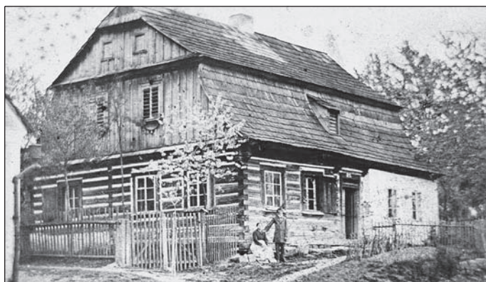
Dole historický snímek, nahoře současné staveniště.
