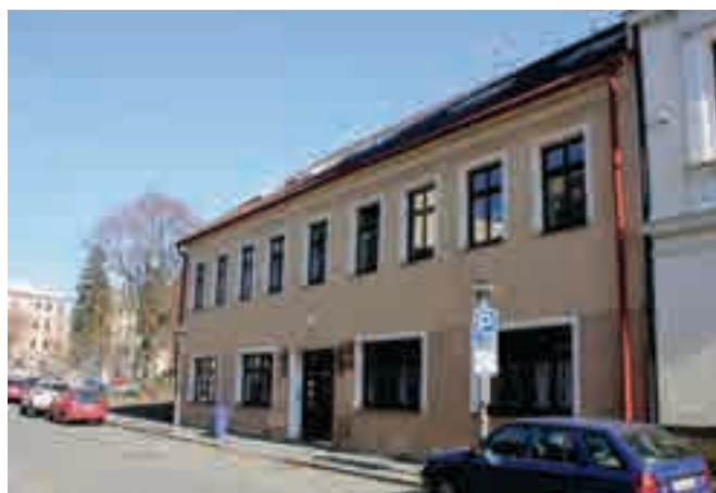
Dům čp. 72 ve Skálově ulici, Turnov
