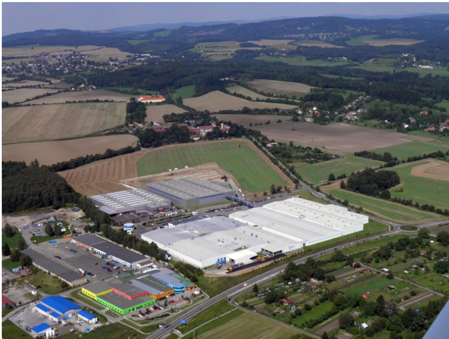
Letecký pohled na průmyslovou zónu v září 2011
