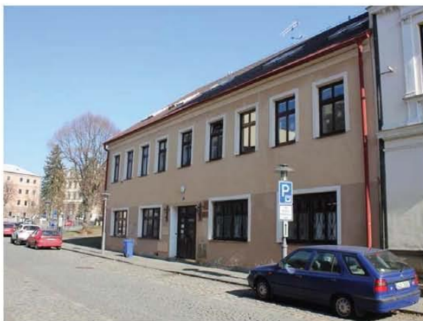
Dům čp. 72 ve Skálově ulici, Turnov
