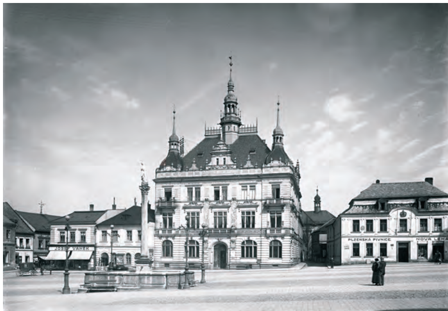
Pohled na severní stranu náměstí v roce 1925.
