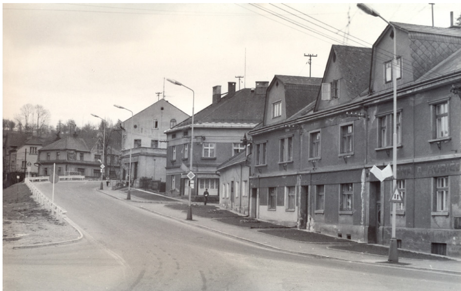
Pohled na pravou stranu ulice Antonína Dvořáka, v popředí skupina tří domů se stavebním povolením vydaným v srpnu 1922.
