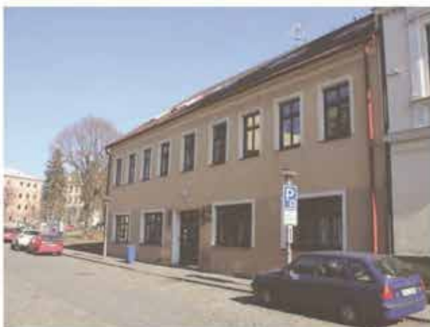
Dům čp. 72 ve Skálově ulici, Turnov
