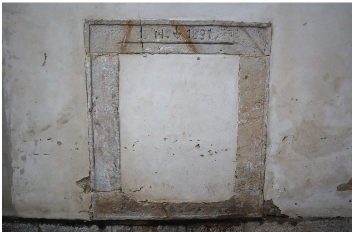
Původní pískovcové okno s normačním značením
