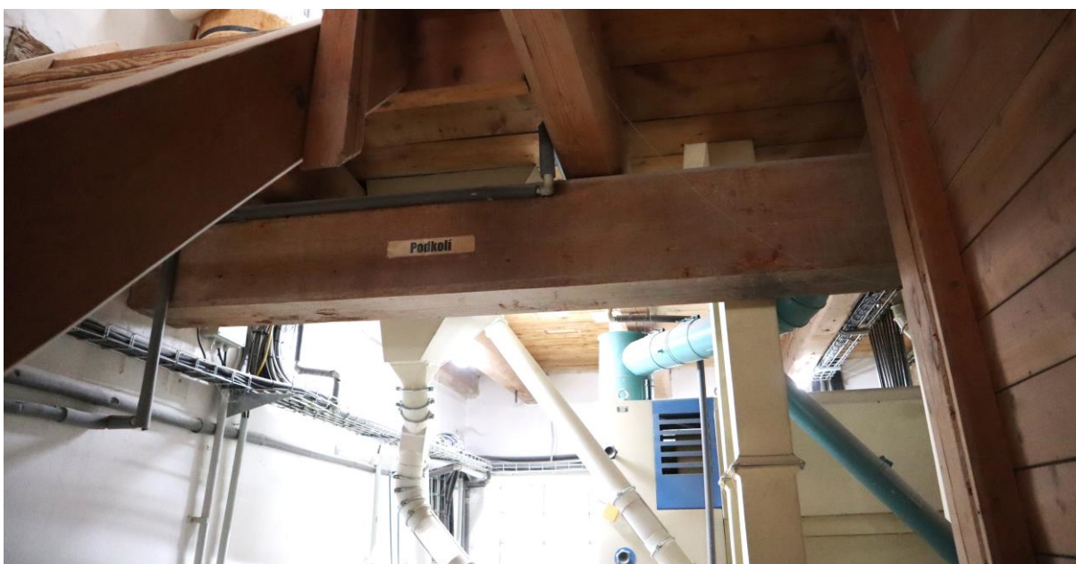
Průvlak zhotovený ze dřeva pokáceného po roce 1816
