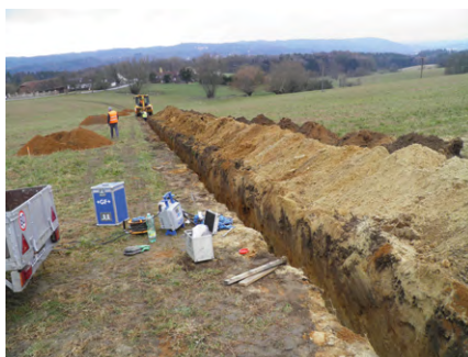
Celkový pohled na výkop směrem na obec Štěpánovice.
