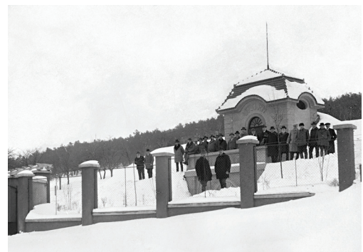
Kolaudace nudvojovického vodovodu (Na Metelce)
