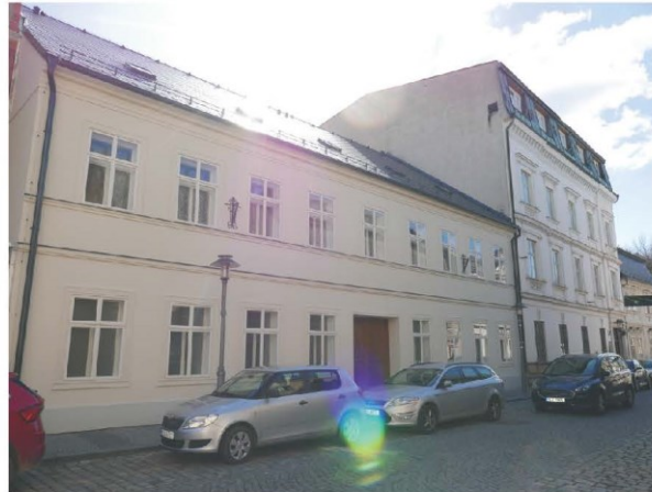
Dům čp. 71 a čp. 72 ve Skálově ulici, Turnov
