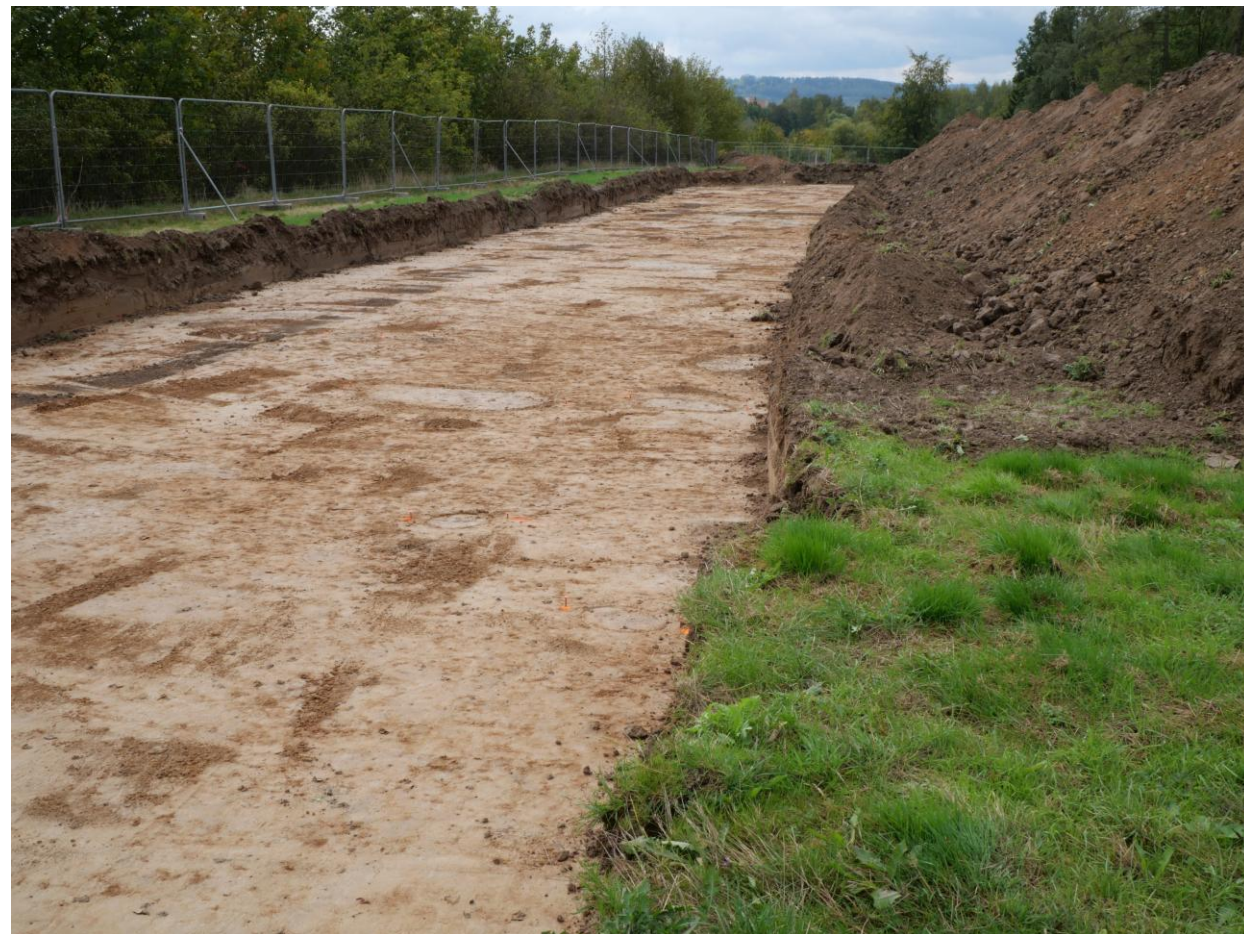
Pohled od severovýchodu
