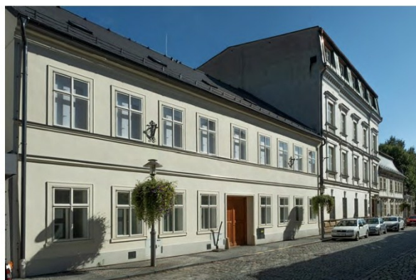
Dům čp. 72 ve Skálově ulici, Turnov
