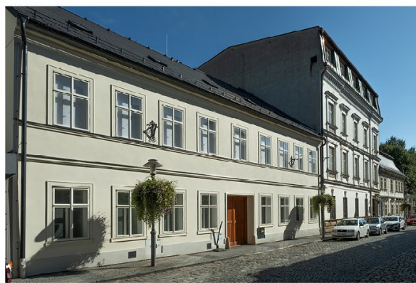
Dům čp. 72 ve Skálově ulici, Turnov
